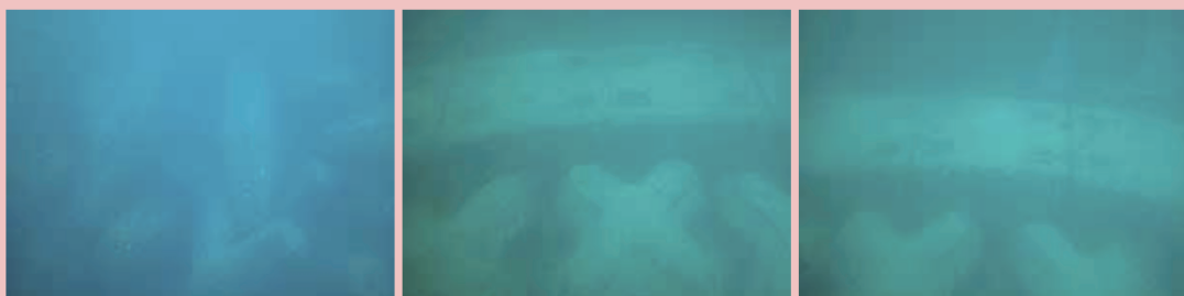
ドルフィン号から見た水面下の工事風景
