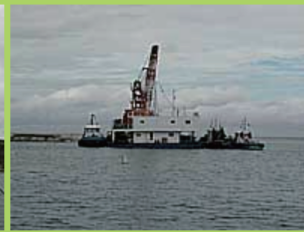
水面では作業船からブロックやテトラを水中のダイバーの指示をもらいながら入れています
