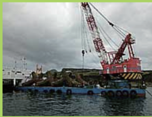
水面では作業船からブロックやテトラを水中のダイバーの指示をもらいながら入れています
